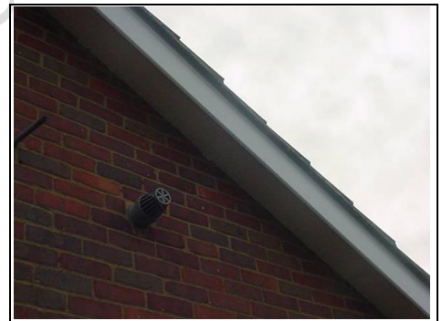
Over-clad bargeboard
